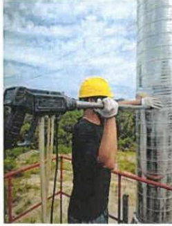
破碎筛分废气排气筒出口
