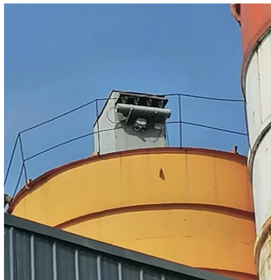
混凝土筒仓顶部布袋除尘器
